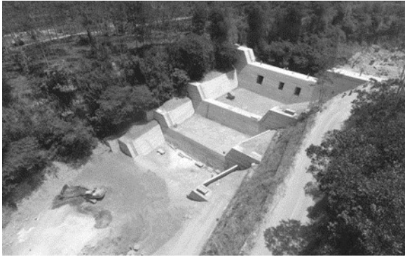
Gambar 8. Sabo dam GE-D2 dengan penambahan sub dam
