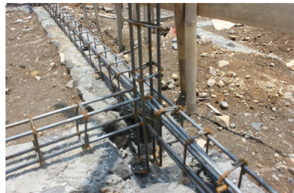
Gambar 1. Detail sambungan baja balok-kolom yang benar dengan putaran potongan yang sesuai untuk dimuat secara lateral (Winarno, 2017).
