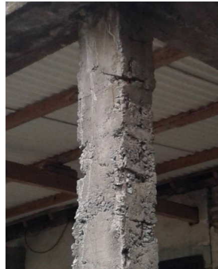
Gambar 3. Bahan beton berkualitas rendah dengan honeycombing (Winarno, 2017)
