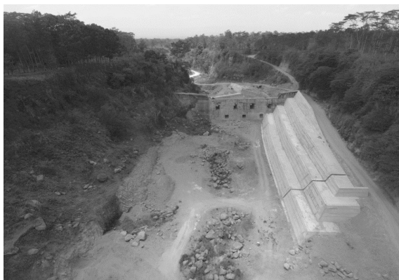
Gambar 11. Tampak dari hulu perkuatan pada sayap sabo dam GE-D3 (Dokumentasi Abipraya, 2019)
