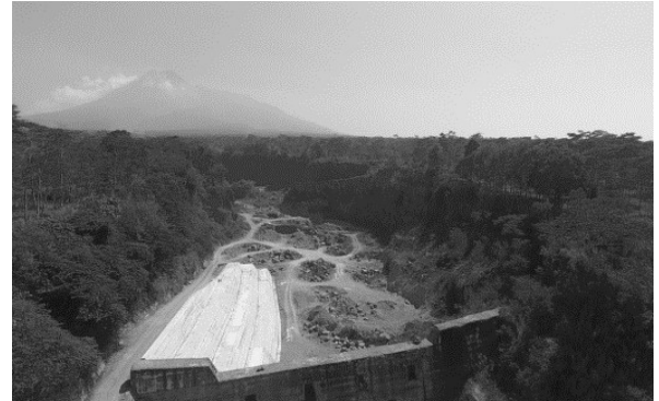
Gambar 12. Tampak dari hilir perkuatan pada sayap sabo dam GE-D3 (Dokumentasi Abipraya, 2019)
