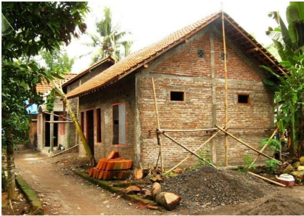
Gambar 2. Rumah yang direkonstruksi sesuai dengan standar kegempaan (Winarno, 2017)
