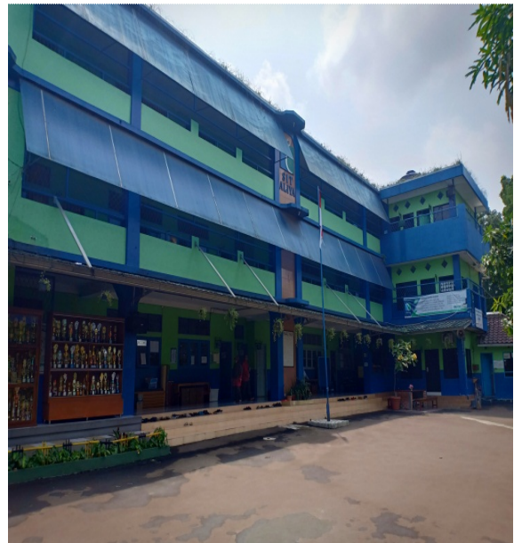
Gambar 2. Tampak Depan gedung Abu Bakar Siddiq
