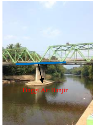
Gambar 37. Tinggi muka air pada Jembatan Pangkalan
