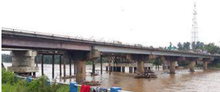
Gambar 2: Geometri Jembatan Sungai Dareh Dharmasraya
