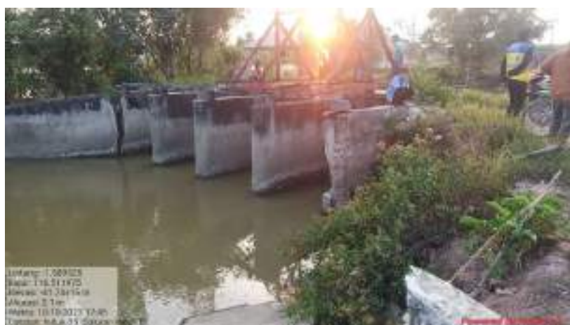
Lampiran . 68 Foto Bangunan Pintu DIR Sebakung
