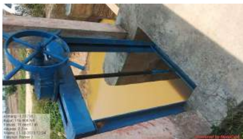
Lampiran . 63 Foto Bangunan Pintu DIR Sebakung
