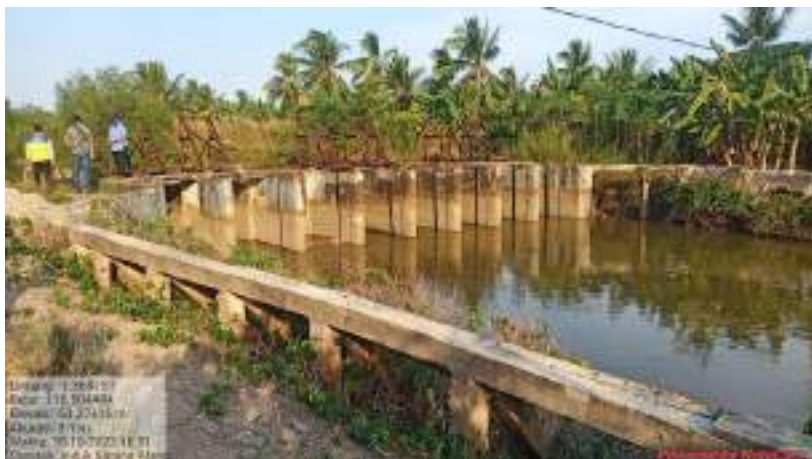
Lampiran . 67 Foto Bangunan Pintu DIR Sebakung
