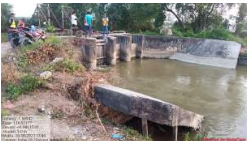
Lampiran . 69 Foto Bangunan Pintu DIR Sebakung
