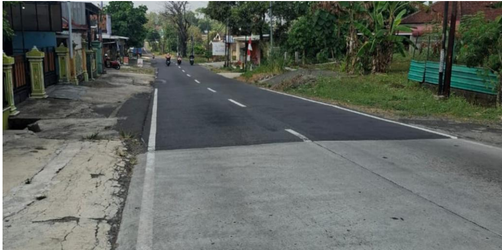
Gambar 5.17 Penanganan Perbaikan Kondisi Permukaan Jalan pada Lokasi Rawan Kecelakaan. (Dokumentasi, 2026)
