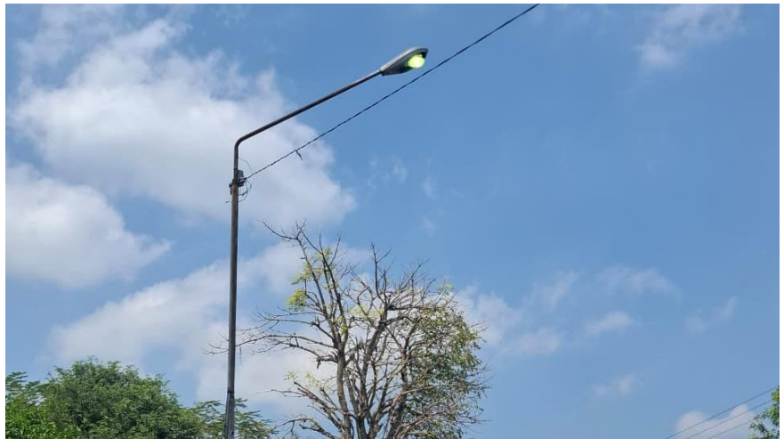
Gambar 2.5 Kondisi Penerangan Jalan (Sumber: Dokumentasi Pribadi, 2026)
