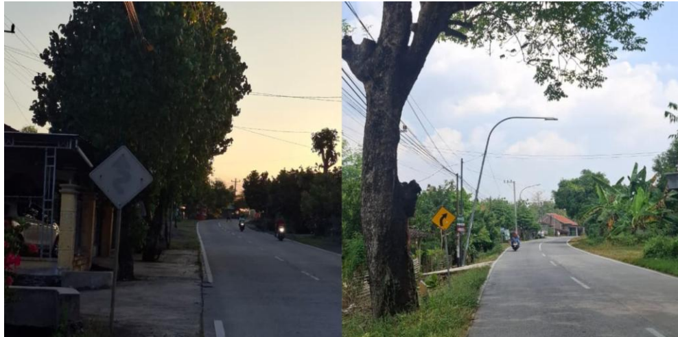
Gambar 5.18 Penanganan Berupa Pemasangan Rambu Lalu Lintas dan Marka Jalan pada Lokasi Rawan Kecelakaan. (Dokumentasi, 2026)
