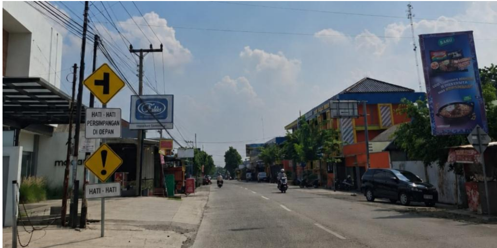
Gambar 5.19 Penanganan Berupa Pemasangan Rambu Peringatan dan Pengendalian Kecepatan Kendaraan. (Dokumentasi, 2026)
